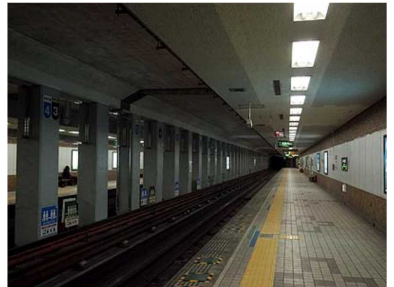
地下鉄中の島駅
