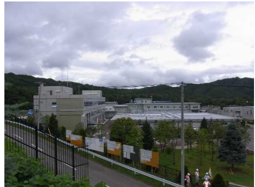
白川第2浄水場
